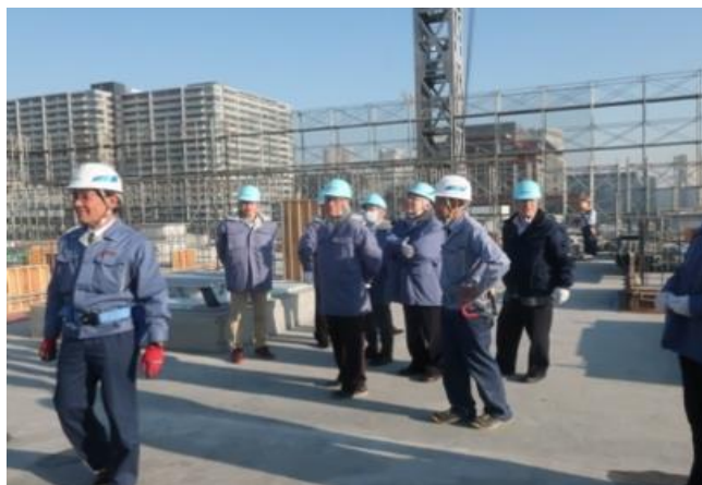
佐々木工事所長に案内され施工階へ
