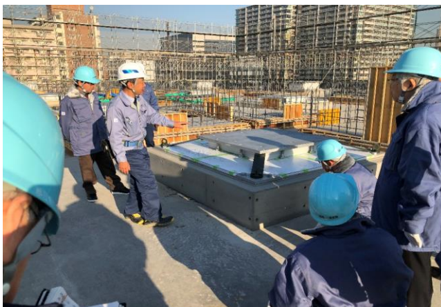
磯作業所長からすべり支承の説明を受ける
